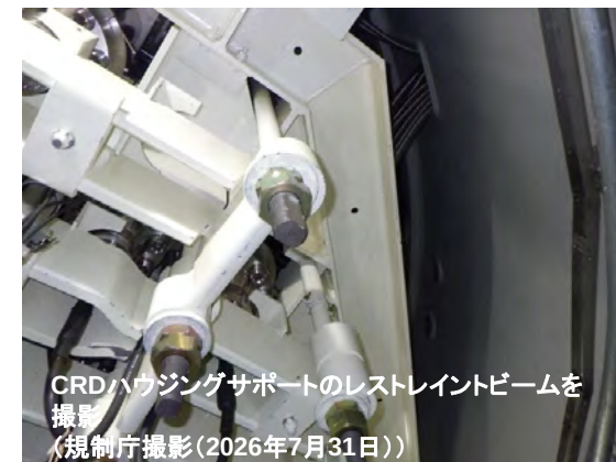
CRDハウジングサポートのレストレイントビームを撮影 (規制庁撮影(2026年7月31日))
