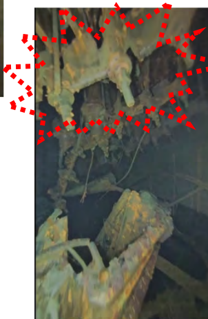
CRDハウジングサポートビーム 支持部(3箇所損傷)
