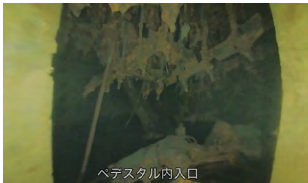
3号機ペDESTル内入口
