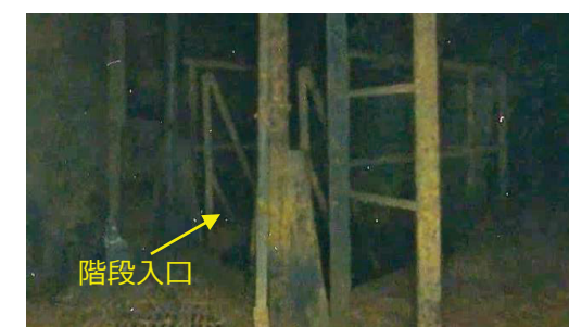
④：地下階段(南)
