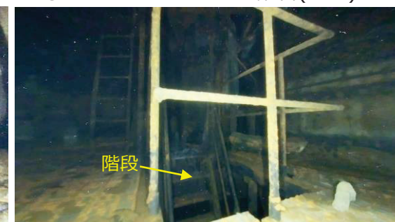
④：地下階段(北)
