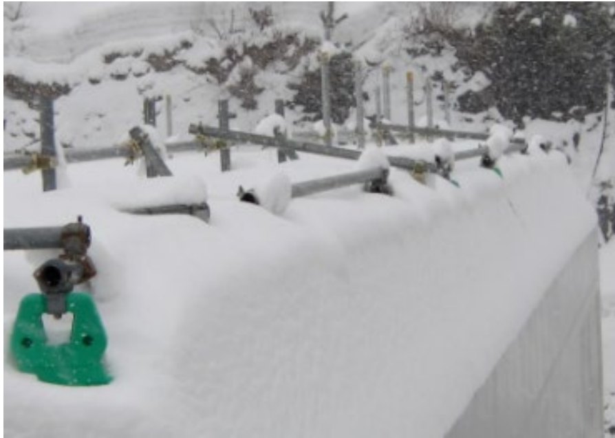
図 13 冬季における埋設設備上部の積雪の状況（2025 年 1 月撮影）
