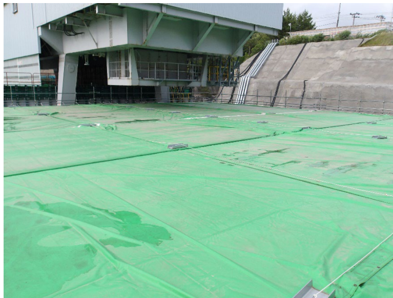
図 8 埋設設備上の防水シート（左奥は埋設クレーン）
