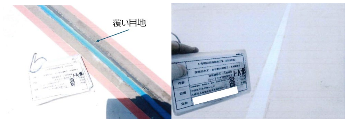
図7 2023年度の1群埋設設備覆い頂部への保修（左：保修中、右：保修後）
