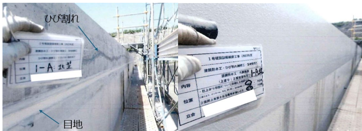
図6 2023年度の1群埋設設備覆い側部への保修（左：保修中、右：保修後）
