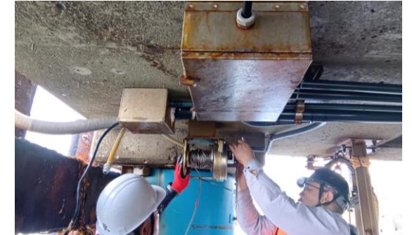
海水系検出器部の修理作業
