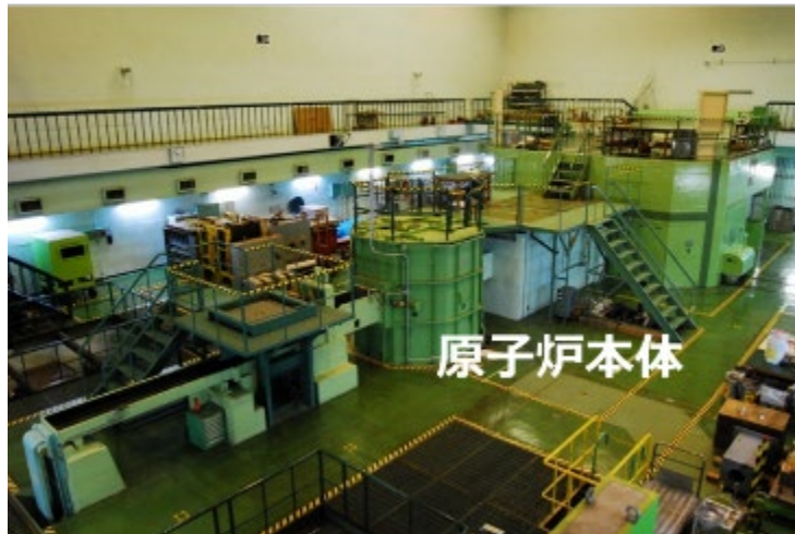
東京大学原子炉の外観
